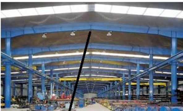
Estructura en Cercha Viga Inclinada
