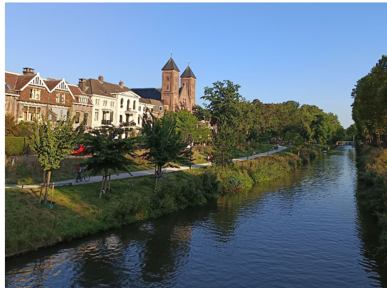
Ejemplo internacional de recuperación del paisajismo en el canal Catharijnesingel en Utrecht, Reino de los Países Bajos. Ecorurbanismo acentuado y respetuoso de la interacción entre zonas verdes, azules y peatonales, en lo que hasta el año 2017 era una avenida transitada. Foto: Ponneffz, 2024.
