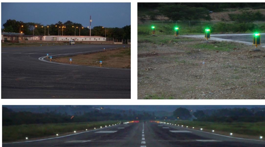
Figura 3.1: Luces de pista con energía solar en Maiquetía. [22]
