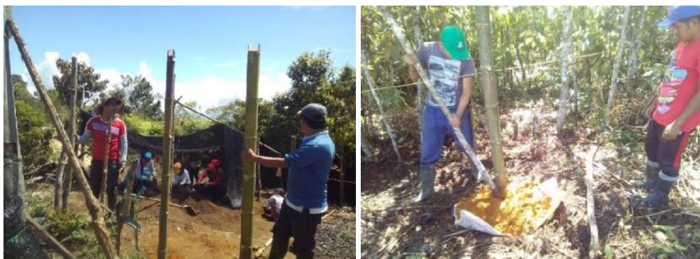
Figura 5 Adecuación del vivero, cerramiento
