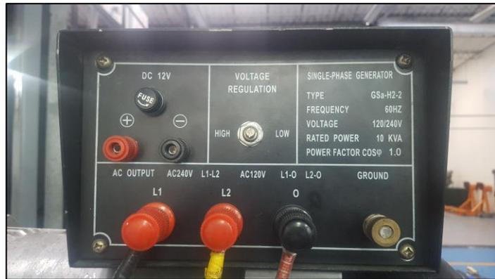
Figura 20. Generador de 10 KVA.
