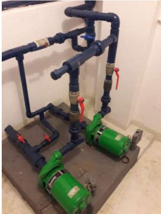
***Imagen No 19 Instalación de bombas de marca Barnes edificación Coquivacoa.***
