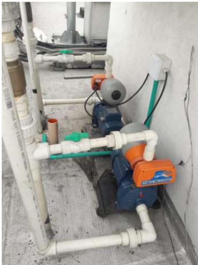
*Imagen No 24 Instalación de bombas de marca Pedrollo CPM 650, Conjunto residencial Prado pinzón. Extraído de Pedrollo S.p.A. (2019).*
